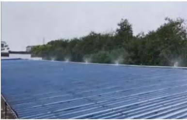
泸州裕同在厂房房顶安装喷淋和水循环系统，通过循环喷水实现厂房降温5-6℃，缓解夏季高温，营造更舒适的工作环境。喷淋过程中的用水可以通过系统进行循环使用，减少水资源的浪费。
