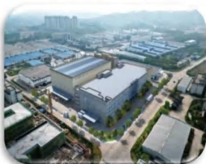
泸州裕同的智能包装产业园项目是绿色工厂的典型代表。该项目使用土建装修设计施工一体化的建设模式，打通传统先土建后装修建设模式中各阶段的信息壁垒，减少设计反复、施工拆改频率，有效节约项目建设过程中消耗的各类资源。结合泸州当地用电峰谷情况，项目引入水蓄冷空调，削峰填谷，为当地电网的平稳运行做出了贡献。在节约能源方面，项目对空压废热进行有效回收，为办公区冬季采暖以及员工生活热水提供稳定的热源，有效实现了能源阶梯利用。
