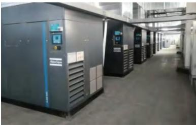
为了节约压缩空气所消耗的能源，许昌裕同在保证安全生产、满足生产负荷的前提下，优化车间供气压力，将车间末端压力设定由0.7Mpa降低至0.6Mpa，既减少了设备配件损耗，又极大降低了空压机能耗。车间用气压力优化项目实施后，每年可节电196.56万千瓦时，同时可减少1,142吨二氧化碳排放。
